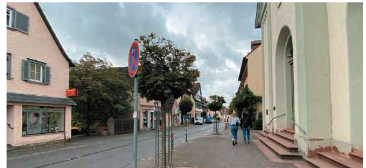
Abbildung 35: Erscheinungsbild Hugenottenstraße, Baumstandorte und sanierungsbedürftiger Pflasterbelag (ProjektStadt 2020)
